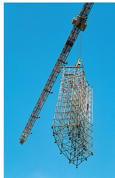
Déplacement à la grue d'une palée
